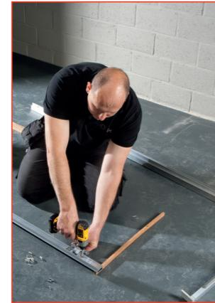
Schroef de scharnier in het Xinnix deurprofiel.
