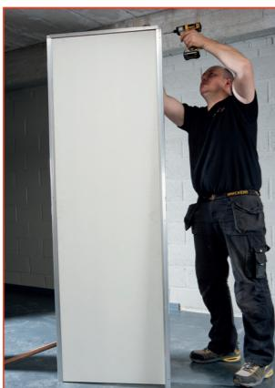
Fixeer met een zelfborende schroef het kopstuk.
