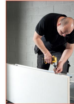
Schroef de scharnier in het deurblad.
