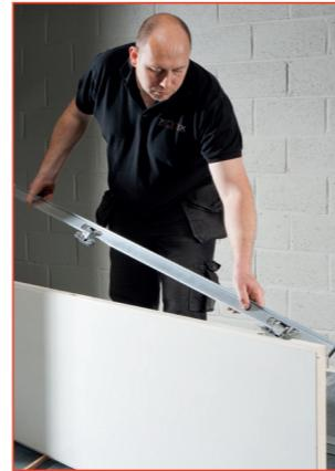
Monter de scharnierzijde van het frame op het deurblad.
