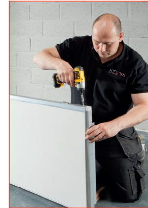
Fixeer met een zelfborende schroef het kopstuk.
