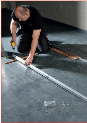
Bevestig het aluminium U vormige montageprofiel.
